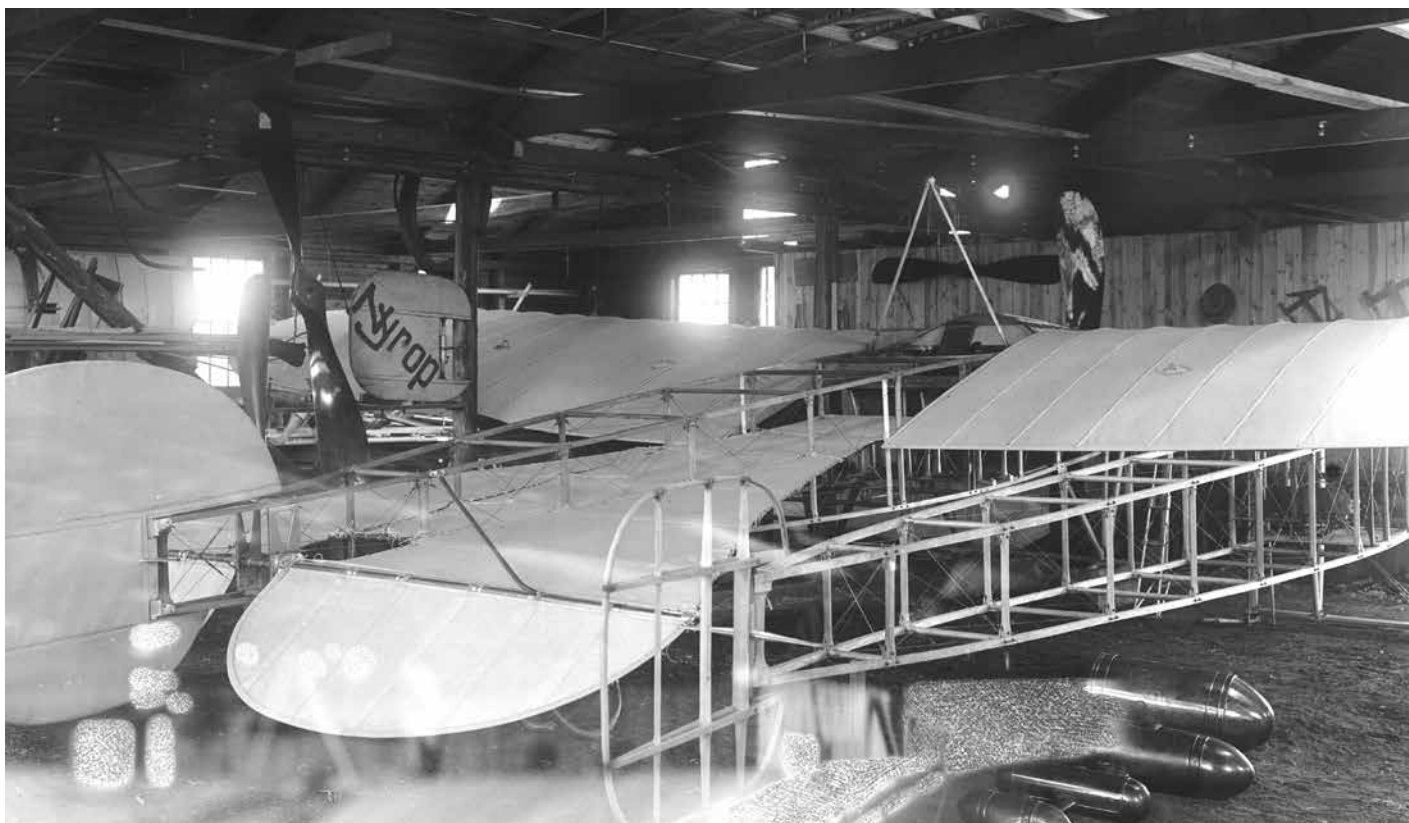
Hjalmar Nyrops bygge av Big Bat , en tvåsitsig Blériot XI, där man satt i bredd, något som var ovanligt vid denna tid, 1910. Bilden är tagen i Nyrops verkstad/båtvarv i Landskrona hamn. Dunkarna på marken är bränsletankar för flygplan. Foto arkiv Svens.
